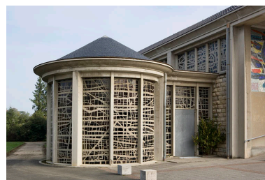
Vue extérieure du baptistère. Phot. Yves Sancey IVR43_20062500725NUCA
