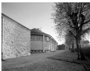
Façade latérale gauche. Phot. Jérôme Mongreville IVR43_19912500023V
