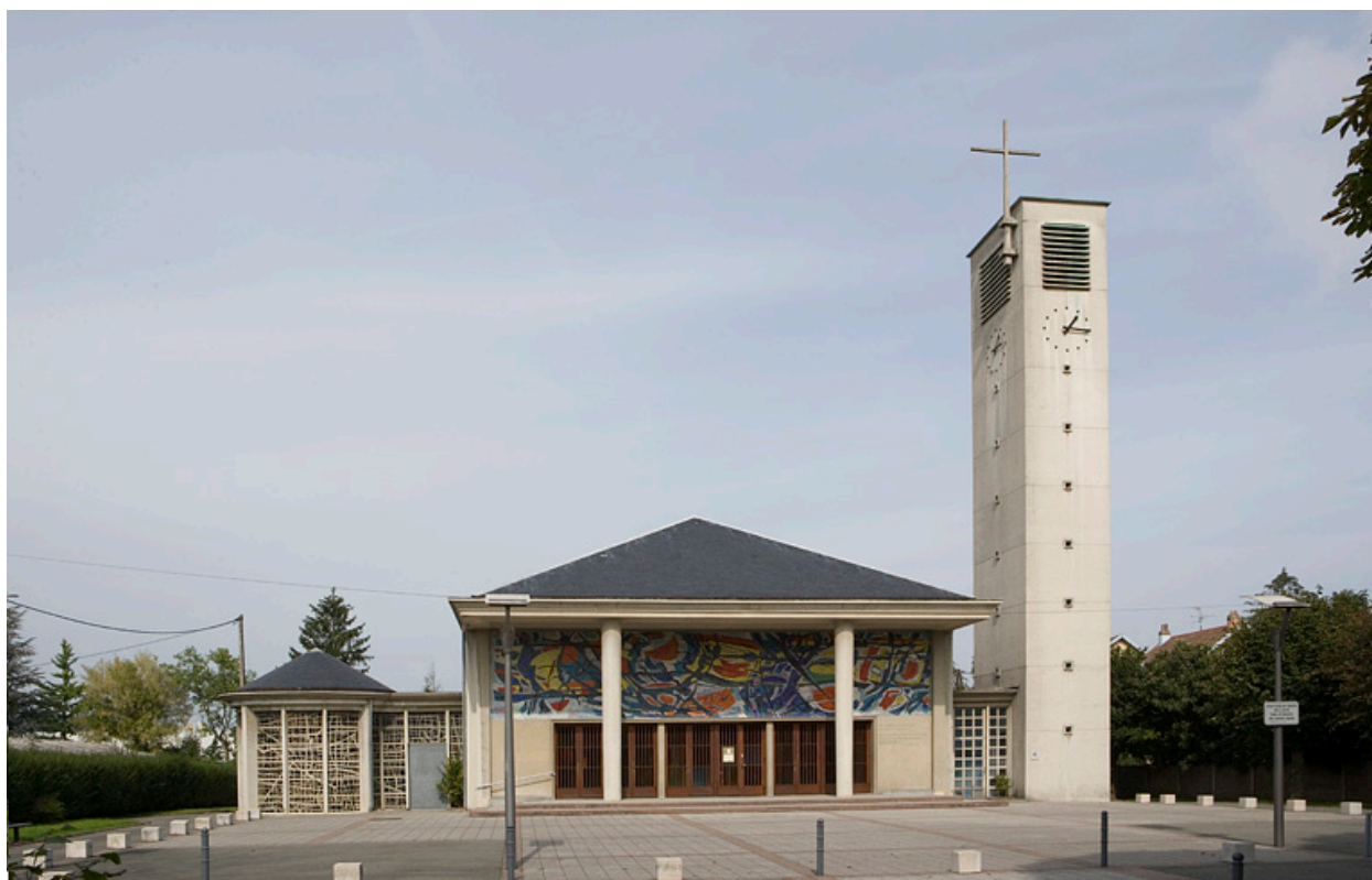
Vue d'ensemble de la façade.
