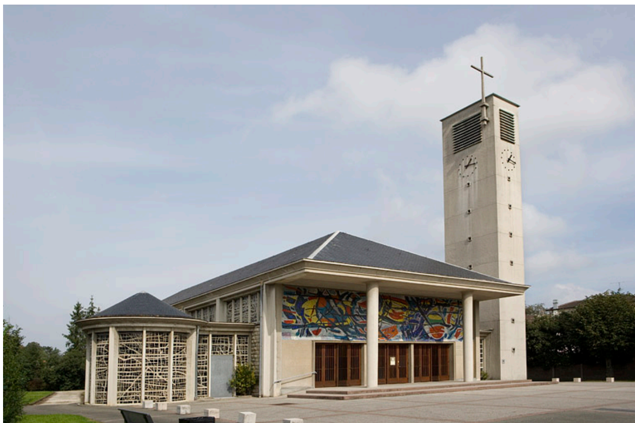
Façade et parvis vue de trois quarts gauche.
