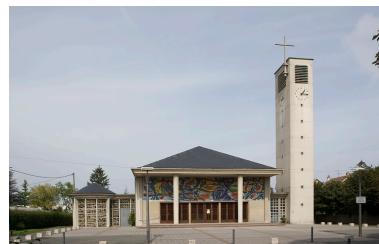
Vue d'ensemble de la façade. Phot. Yves Sancey IVR43_20062500719NUCA
